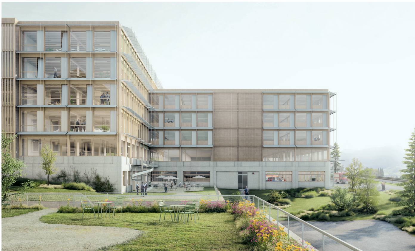
Vorfabrizierte Holzmodulfassade mit einem Glasanteil von 50%
