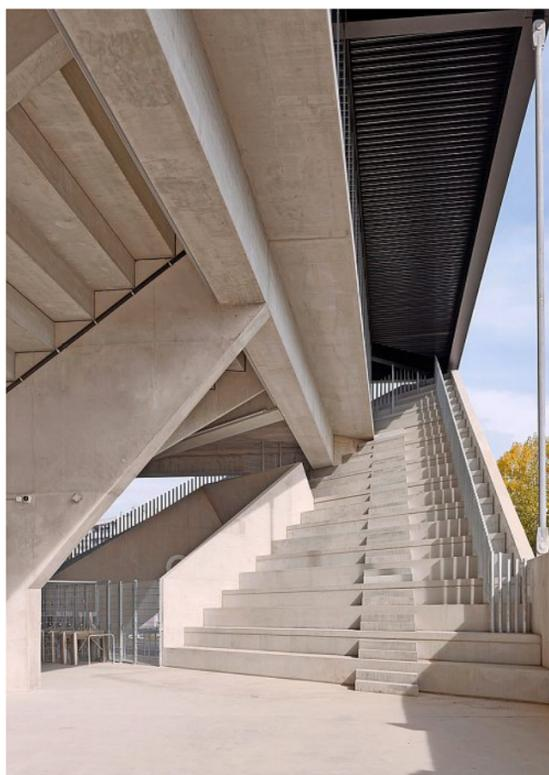
Spezielle Eingangssituation: Auf der Innenseite sind die aufgeklappten Ecken als Treppen konzipiert
