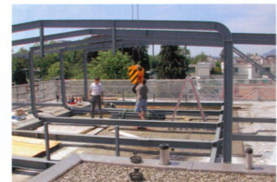
Die Stahlkonstruktion besteht hauptsächlich aus IPE-Profilen, die zu Rahmen geschweisst auf die Baustelle geliefert wurden. Eine leichtere Konstruktion ist kaum möglich.
