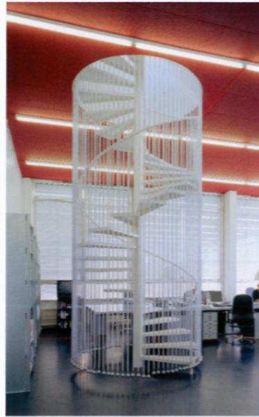
Das neue Obergeschoss wird über das bestehende Bürogeschoss durch eine Wendeltreppe erschlossen. Geplant war ursprünglich die vollflächige Bebauung der Dachfläche.
