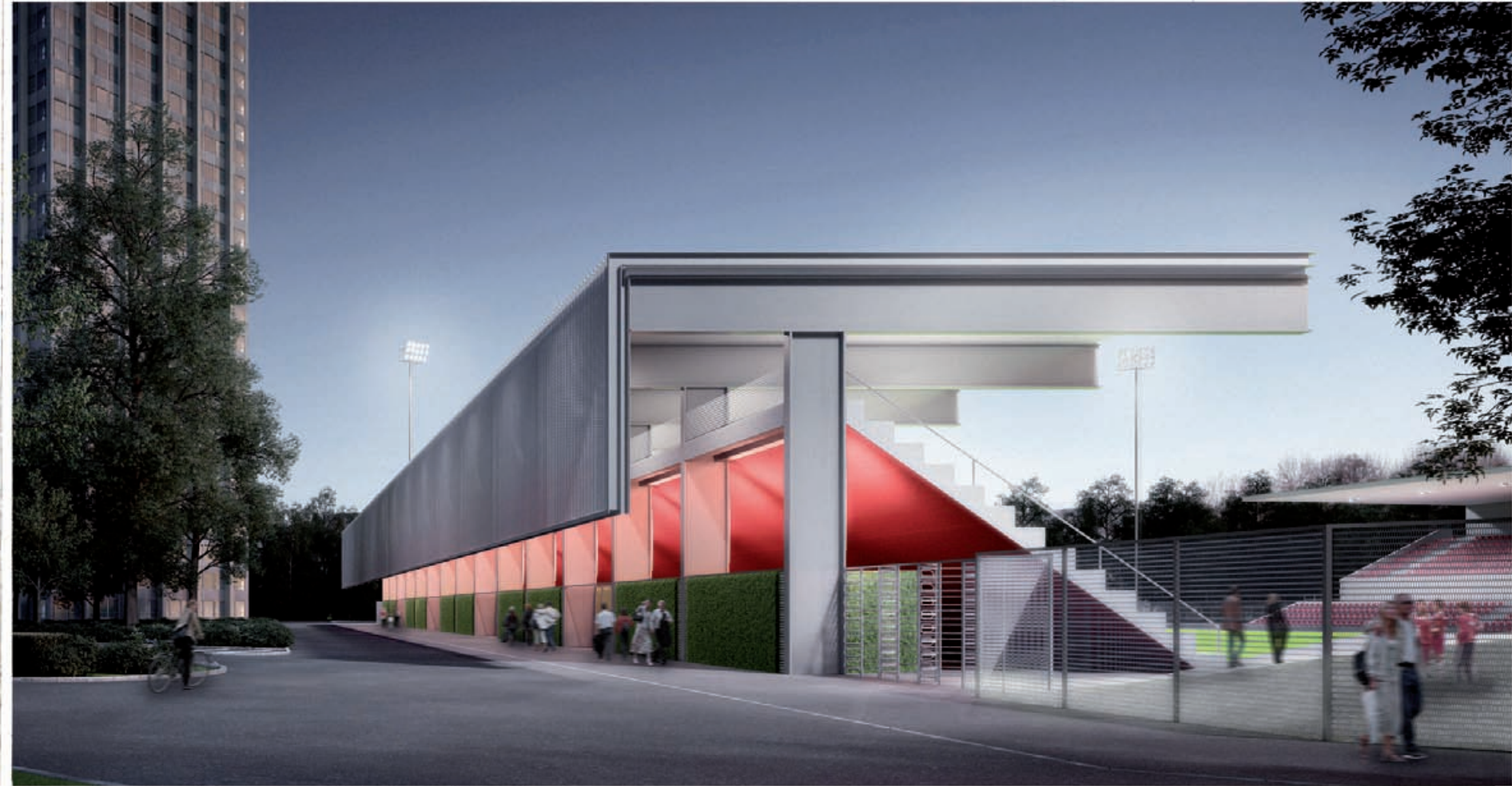
Schon im November soll die neue Gegentribüne der «Schützi» fertig sein. Gebaut wird sie aus vorgefertigten Stahl- und Betonelementen. Visualisierung: Raumleiter GmbH
