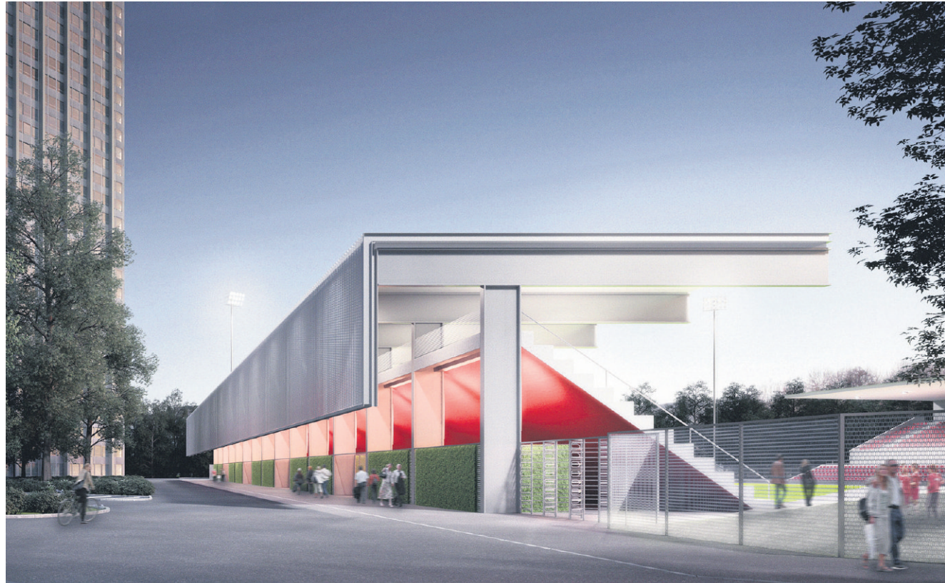
Das Dach der neuen Tribüne ruht auf massiven Stahlträgern. Die alte Tribüne gegenüber wird saniert. Visualisierung: Raumgleiter
